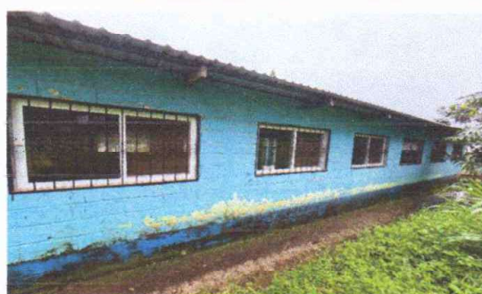
Foto 2: SELLADO DE GRIETAS Y FISURAS EN MUROS Y CIRCULACION CON MALLA METALICA
