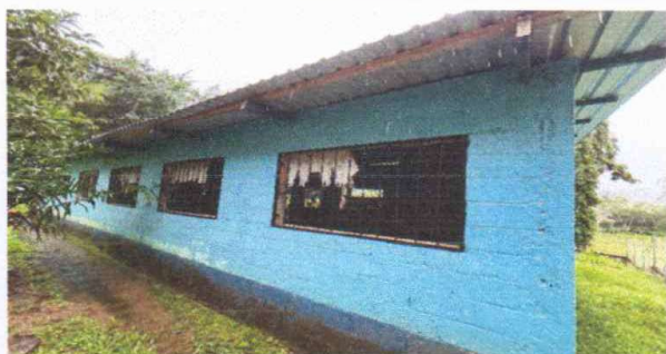
Foto 3: PINTURA EN MUROS EXTERIORES E INTERIORES
