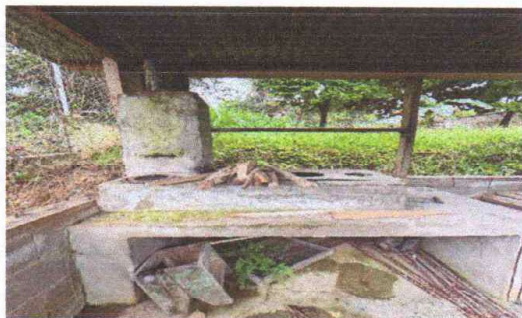
Foto 7: SUSTITUCIÓN DE LÁMINA, POR LÁMINA TROQUELADA ALUZINC CALIBRE 26 EN COCINA
