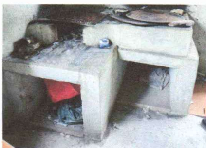
Foto 3: Sustrucción de estufa rural (completa) incluye chimenea y plancha de metal
