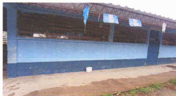
Foto 2: SUSTITUCIÓN DE BALCONES DE METAL
