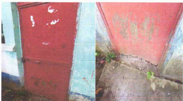
Foto 1: SUSTITUCIÓN DE PUERTA DE METAL
