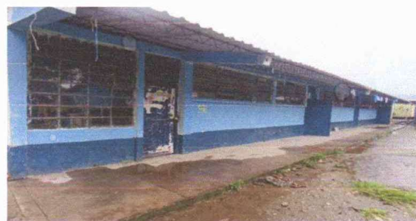
Foto 4: PINTURA DE MUROS EXTERIORES O INTERIORES DE 3 AULAS Y COCINA
