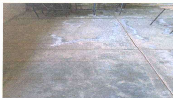
Foto 2 : cambio de torta de piso de cemento por piso ceramico
