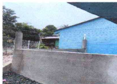
Foto 8: Instalacion de estructura de metal
