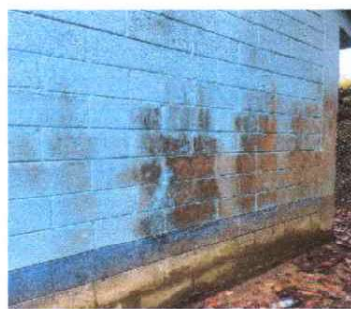
Foto 4: pintura de exteriores e interiores
