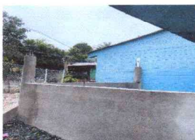
Foto 7: Instalacion de lamina troquelada
