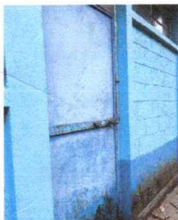
Foto 1: Sustrución de puertas de metal
