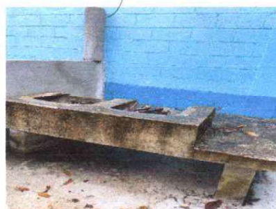
Foto 6: Instalacion de chimenea
