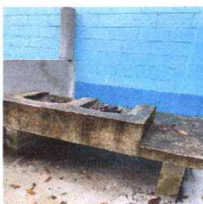
Foto 5: Reparacion de estufa artesanal
