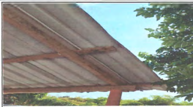
Foto 2: SUSTITUCIÓN DE LAMINA POR LAMINA ALUZINC 28
