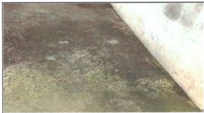
Foto 4: SUSTITUCIÓN PISO TORTA DE CEMENTO
