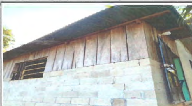
Foto 1: REMOZAMIENTO DE PARED DE COCINA
