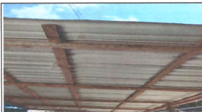
Foto 3: SUSTITUCIÓN DE ESTRUCTURA SOPORTE DE MADERA POR METAL
