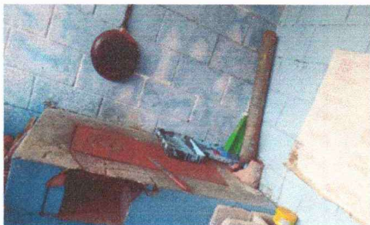
Foto1: SUSTITUCIÓN DE ESTUFA RURAL COMPLETA INCLUYE CHIMENEA Y PLANCHA DE METAL
