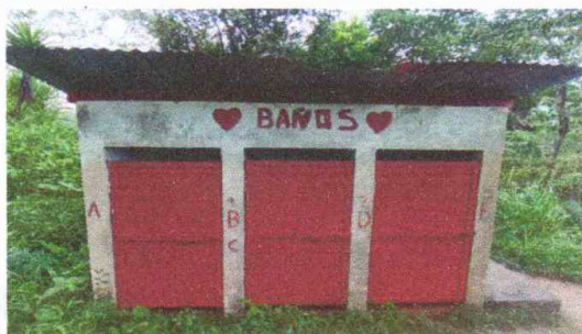
Foto 5: PUERTA DE METAL MANTENIMIENTO A ESTRUCTURA (LIJADO, CAMBIO TU BO, CEPILLADO SUJECCIONES APLICACIÓN DE PINTURA)
