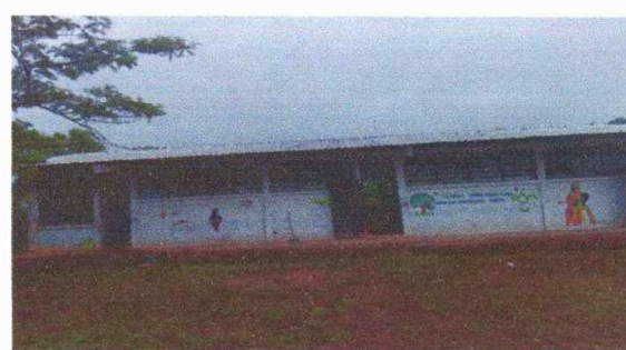
Foto 4: SUSTITUCIÓN DE LAMINA POR LAMINA TROQUELADA ALUZINC CALIBRE 26
