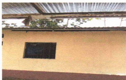
Foto 11: canal de tubo pvc
