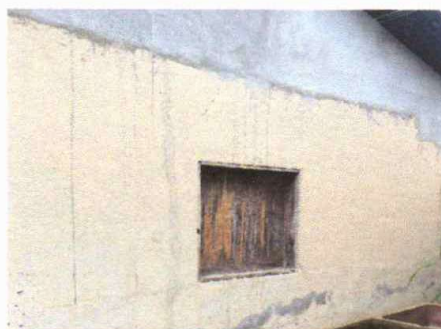
Foto 2: Sustitución de ventana de madera por balcón
