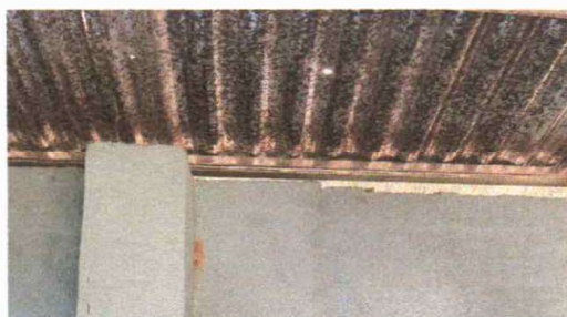
Foto 5: sustitución de lamina acanalada por lamina acanalada
