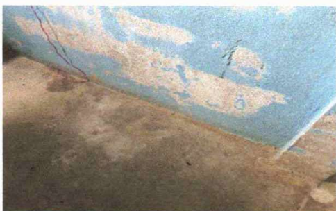
Foto 9: sustitución de piso cemento por piso granito
