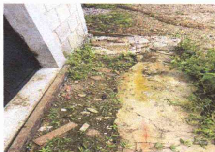
Foto 10: Sustitución de piso torta
