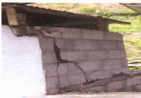
Foto 1: Reparación de pared de la cocina
