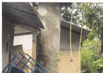
Foto 8: sustitución de tubo pvb para agua potable
