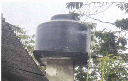
Foto 7: sustitución de rotoplas
