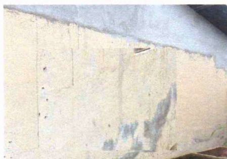
Foto 6: pintura de paredes interior exterior
