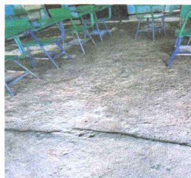
Foto 4: SUSTITUCIÓN DE TORTA DE CONCRETO
