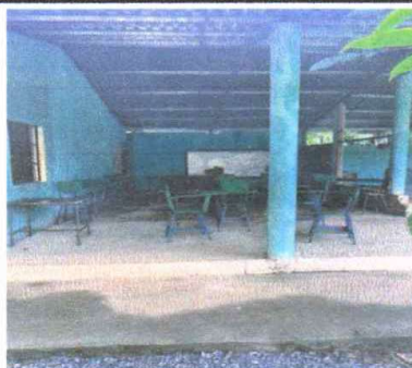
Foto 6: REPARACIÓN DE MURO PERIMETRAL DE BLOCK COCINA
