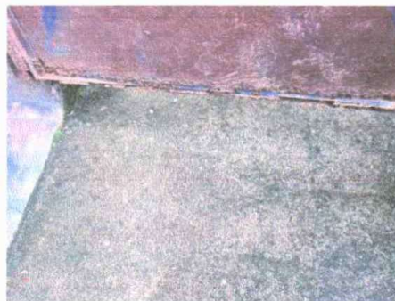
Foto 2: SUSTITUCIÓN DE PISO DE GRANITO
