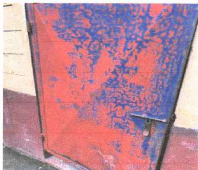
Foto 1: SUSTITUCION DE PUERTA PARA BAÑOS
