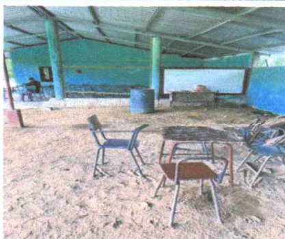
Foto 7: SUSTITUCIÓN DE TORTA DE CONCRETO
