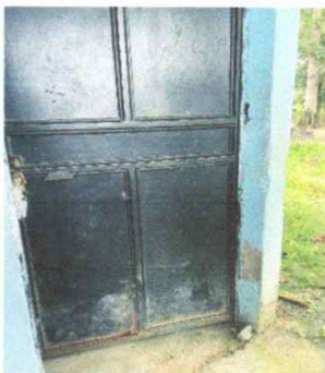
Foto 7: sustitucion de puerta de metal
