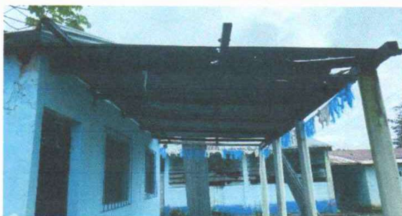
Foto 3: SUSTITUCION DE ESTRUCTURA DE MADERA POR DE METAL
