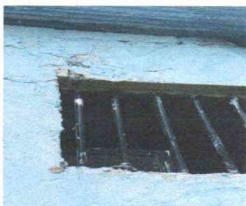
Foto 5: SUSTITUCION DE BALCON
