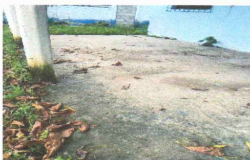
Foto 11: SUSTITUCION DE PISO TORTA POR PISO DE GRANITO
