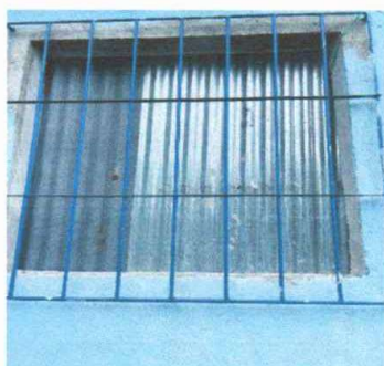
Foto 9: sustitucion de ventana de metal
