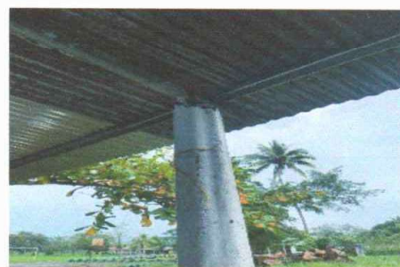
Foto 12: Reparacion de bace
