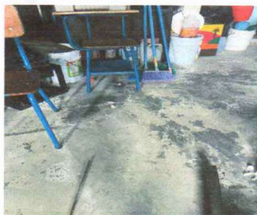
Foto1: SUSTITUCION DE PISO POR PISO GRANITO
