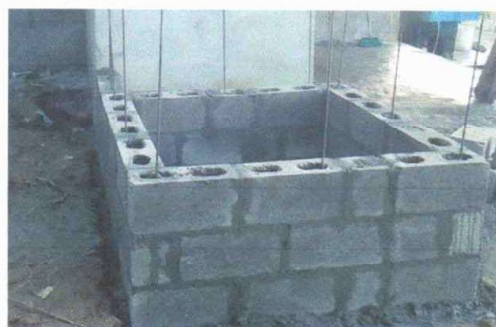
Foto 10: Instalacion de pila
