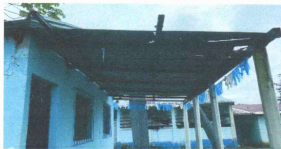
Foto 2: SUSTITUCION DE LAMINA ACANALADA POR LAMINA TROQUELADA
