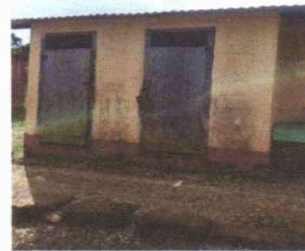
Foto 4: SUSTITUCIÓN DE DOS PUERTAS DE MADERA POR METAL EN BAÑO
