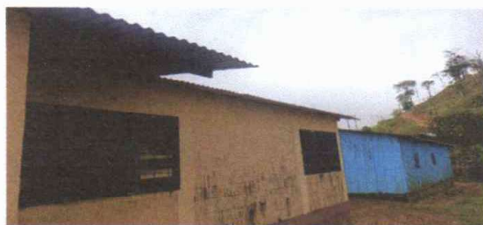
Foto7: SUSTITUCIÓN DE LAMINA
