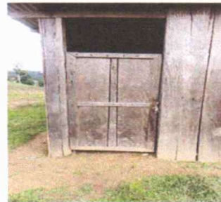
Foto 2: SUSTITUCIÓN DE PUERTA DE MADERA POR METAL
