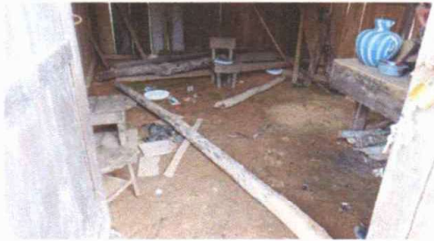
Foto 1: SUSTITUCIÓN DE TORTA DE CEMENTO
