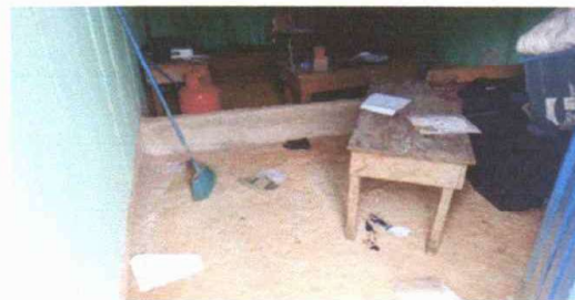
Foto 6: SUSTITUCIÓN DE FRIBOLIT
