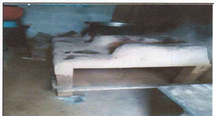
Foto 3: sustitucion de plancha de metal de 3 hornillas
