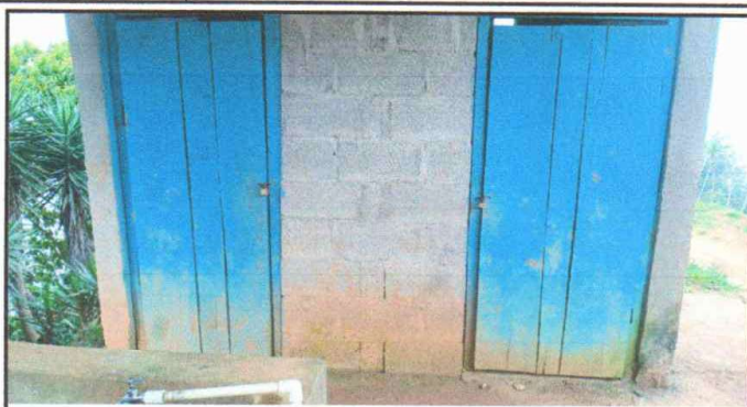
Foto 2: SUSTITUCION DE PUERTAS EN BAÑOS
