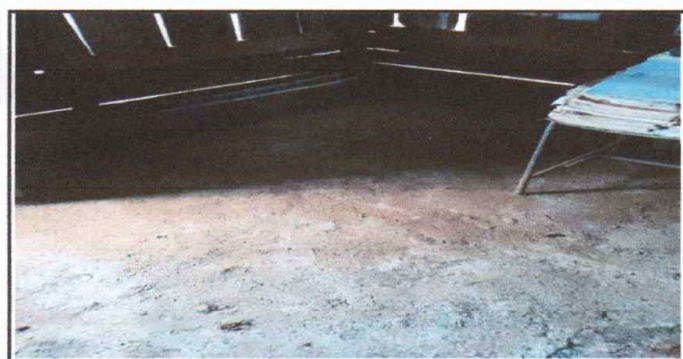
Foto 5: susticion de piso de torta de concreto en baños
