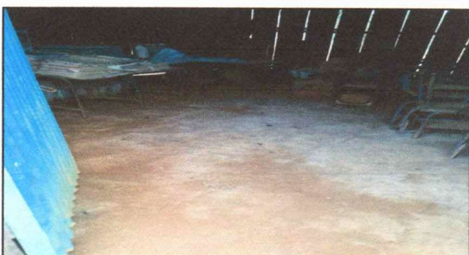
Foto 4: SUSTITUCION DE PISO DE TORTA DE CEMENTO
