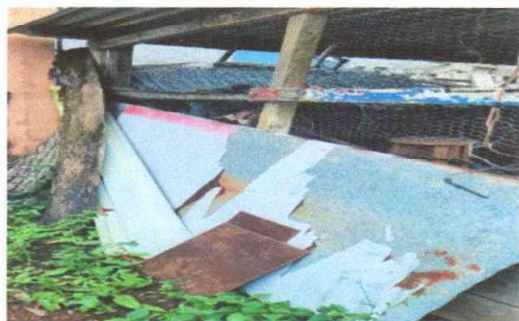
Foto1: REMOZAMIENTO DE COCINA
