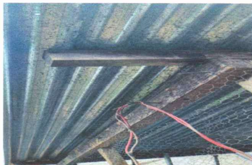
Foto 2: SUSTITUCIÓN DE LAMINA POR LAMINA ALUZINC 26
