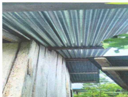
Foto 2: SUSTITUCIÓN DE LAMINA POR LAMINA ALUZINC CALIBRE 26
