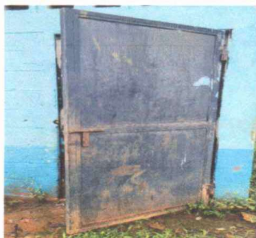
Foto 3: SUSTITUCIÓN DE PUERTA EN SERVICIO SANITARIO
