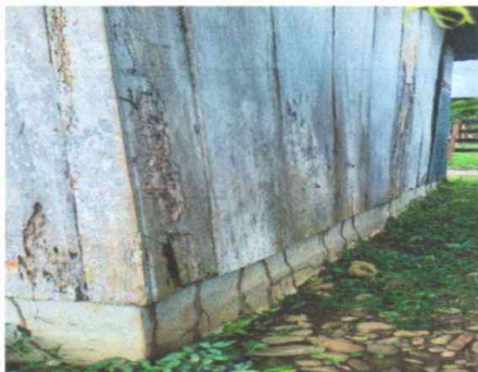
Foto 1: REMOZAMIENTO DE PARED
