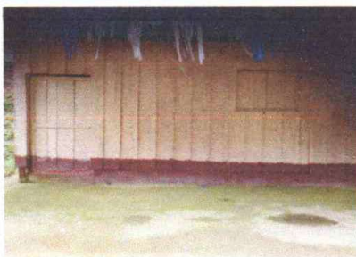
Foto 5: SUSTITUCION DE PUERTAS DE MADERA POR PUERTAS DE METAL
