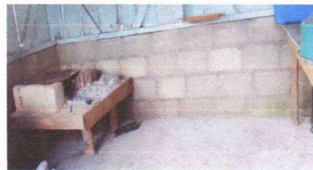
Foto 4: REMOZAMIENTO DE COCINA
