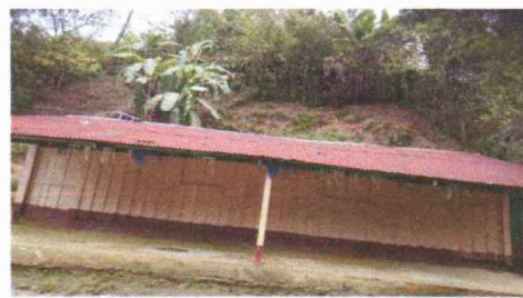
Foto 2: SUSTITUCION DE TECHO LAMINA TROQUELADA ALUZING CALIBRE 26
