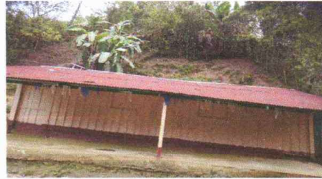
Foto 8: SUSTITUCION DE PINTURA EN PAREDES
