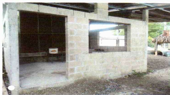
9.1 Fabricacion e instalacion de puerta de metal
