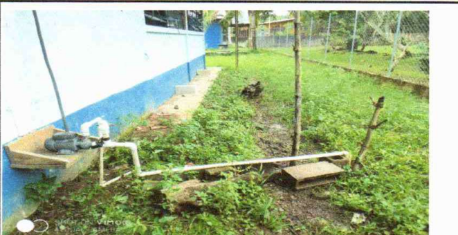
6.1 sustitucion e instalacion de tuberia principal para rotoplas, baños y cocina .
