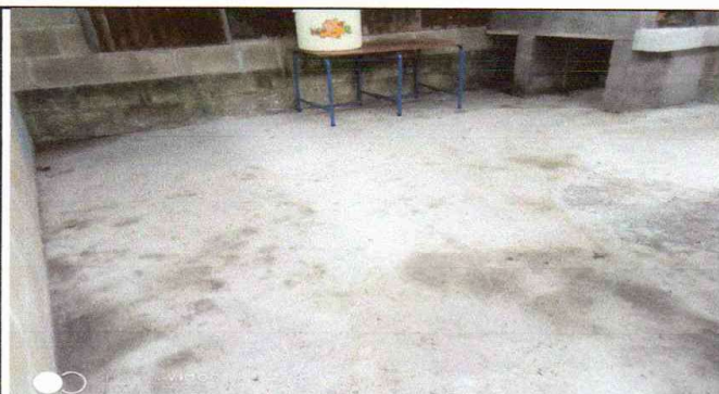
4.1 sustitucion de piso de cemento por ceramica para la cocina
