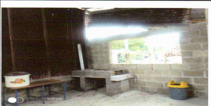
5.1 sustitucion de estufa rural completa.
