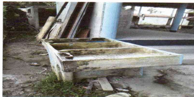
8.1 sustitucion e instalacion de pila de cemento de dos lavaderos.
