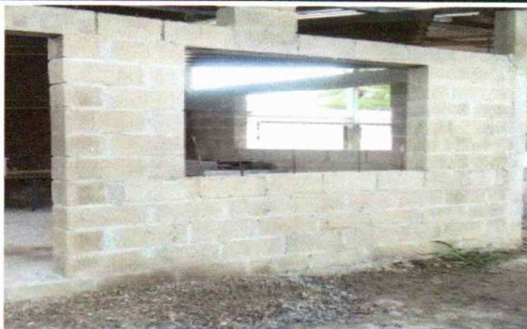
10.1 Fabricacion e instalacion de ventanas
