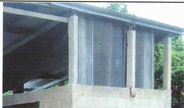
Instalacion de muro de block, y solera en la cocina
