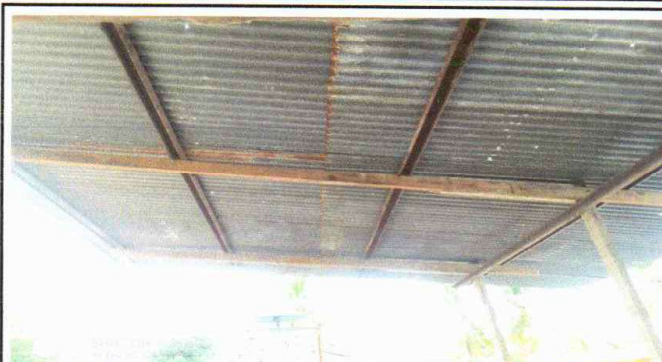
2.1 Sustitucion de estructura de soprte de metal por metal.
