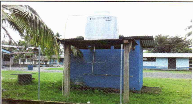
3.1 sustitucion de torre de madera por columnas de concreto y losa
