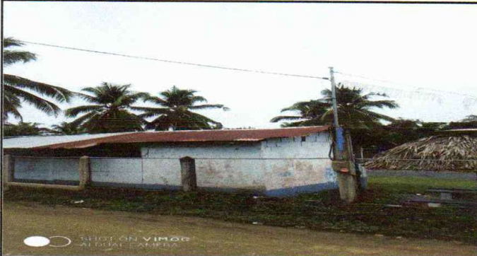
1.1 sustitucion de lamina corriente calibre 28 por lámina troquelada aluzinc calibre 26.
