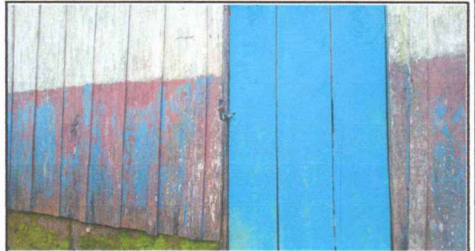
Foto 2: SUSTITUCION DE PUERTAS EN AULA
