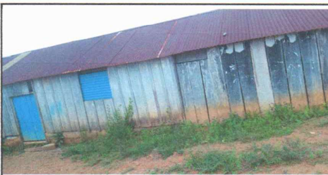
Foto 5: instalacion de lamina troquelada aluzinc calibre 26
