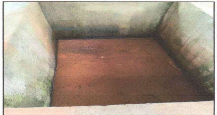
Foto 4: Sustrucion de deposito de agua de 1,100 litros
