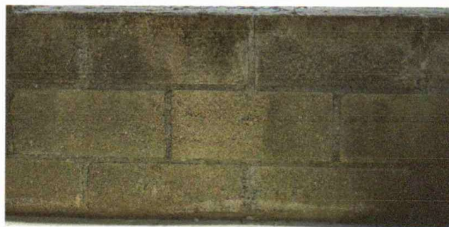
Foto 8 Repello en muro
