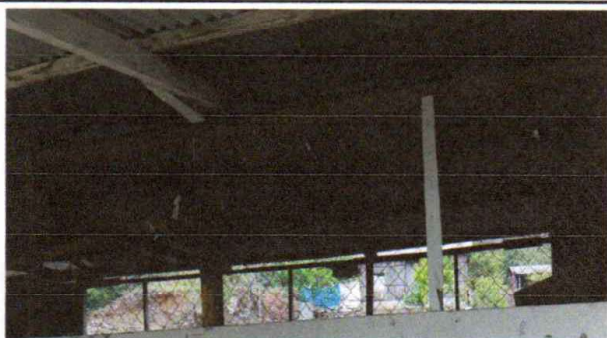
Foto 5 Sustitución de ventana de malla por estructura de metal
