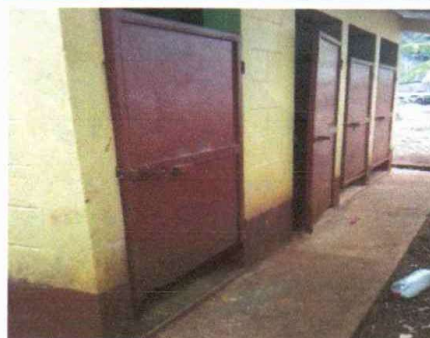
Foto 4 Sustitución de puertas de servicios sanitarios.
