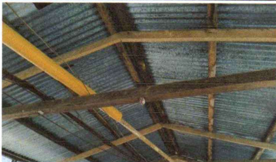
Foto 1 Sustitución de lámina por lámina troquelada alucin calibre 26
