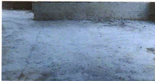
Fotro 7 Sustrucción de piso de torta de concreto
