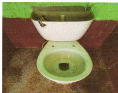
Foto 6 Sustitución de accesorios de inodoro (contra llave, tubo de abasto y tanque)
