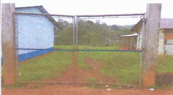
Foto 1: SUSTITUCIÓN DE PORTON DE METAL
