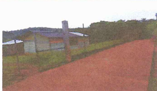
Foto 2: SUSTITUCIÓN DE PORTON DE METAL
