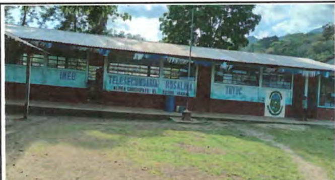
Foto 3: PINTURA A MUROS EXTERIORES E INTERIORES
