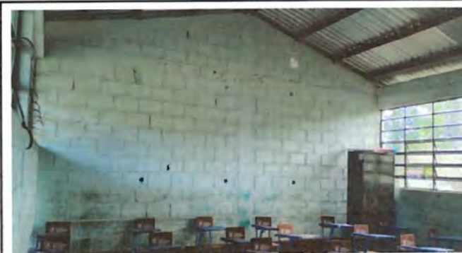
Foto 4: PINTURA A MUROS EXTERIORES E INTERIORES
