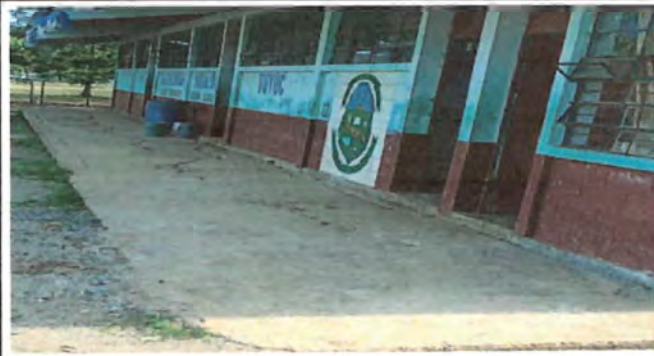
Foto 2: REPARACION DE PISO DE TORTA A CONCRETO
