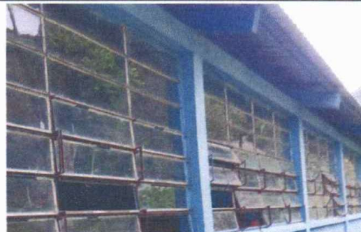
Foto 4: Mantenimiento a estructura de metal de ventana
