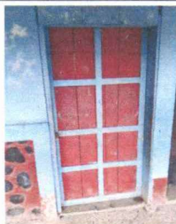
Foto 1: Sustrucción de lámina, por lámina troquelada Aluzinc Calibre 26
