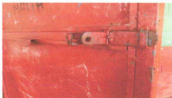
Foto 4: Sustitución de puerta en sanitario
