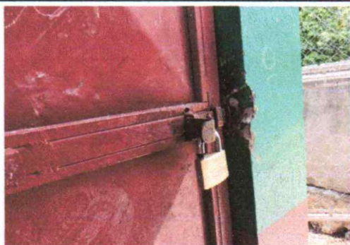
Foto 3: Sustitución de chapas de puertas
