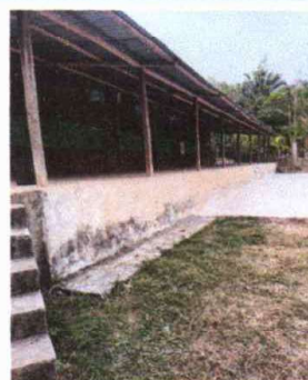
Foto 6: Sustitución de baranda de metal.
