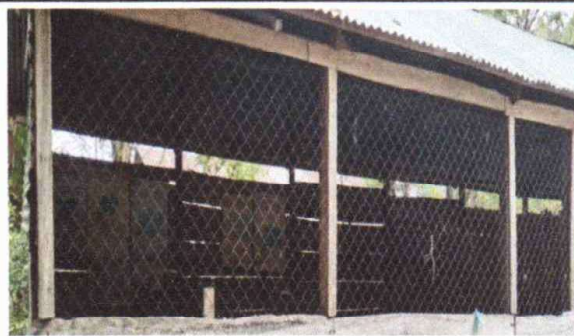
Foto 4: Sustitución de ventanas de madera por metal
