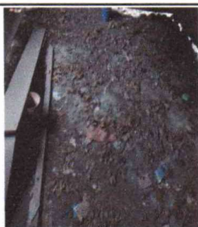
Foto 5: Sustitución de piso de torta de concreto
