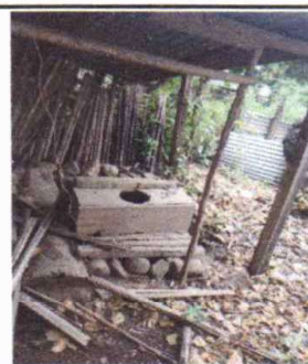
Foto 6: Sustitución de letrina por inodoro
