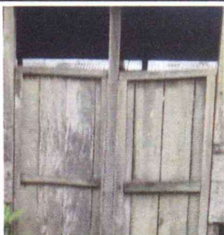
Foto 3: Sustitución de puertas
