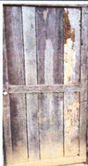
FOTO 3: SUSTITUCION DE PUERTA DE MADERA POR METAL
