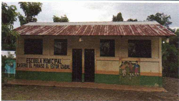
FOTO 1: SUSTITUCION DE LAMINA POR LAMINA TROQUEALDA
