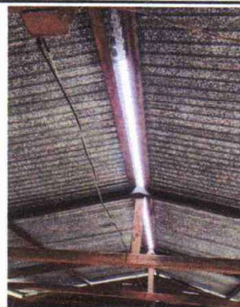
FOTO 2: SUSTITUCION DE ESTRUCTURA DE MADERA POR METAL
