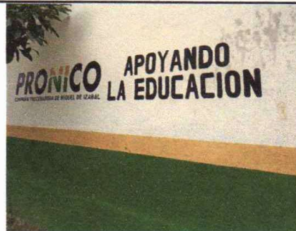
FOTO 4: PINTURA MUROS INTERIOR Y EXTERIOR
