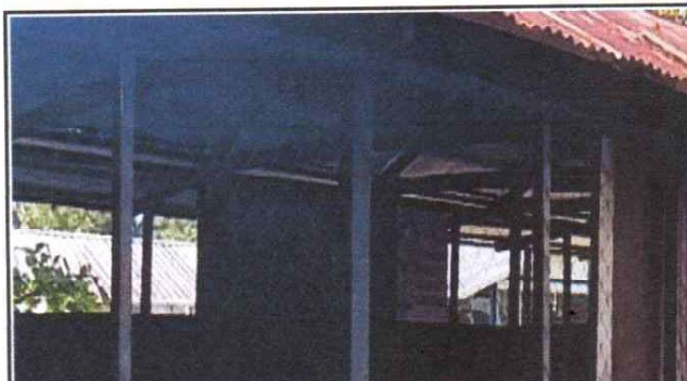
Foto 4: Sustitución de balcones de metal
