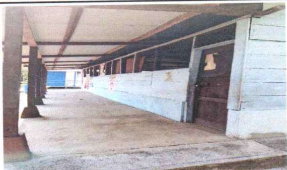
Foto1: Sustitución de laminas por laminas troqueladas aluzinc calibre 26
