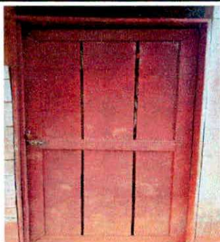
Foto 3: Sustrucción de puerta de madera por metal
