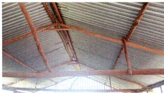
Foto 2: Sustrucción de estructura de techo de madera, por metal.
