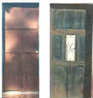
Foto1:Sustitución de lámina, por lámina troquelada aluzinc de 12 pies calibre 26
