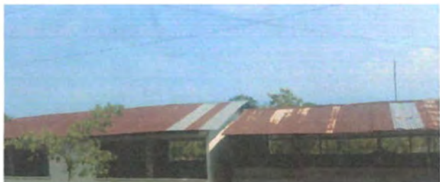
Foto1:Sustitución de lámina, por lámina troquelada aluzinc de 12 pies calibre 26
