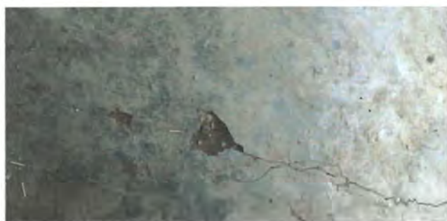
Foto 5: Sustitución de piso de torta de concreto
