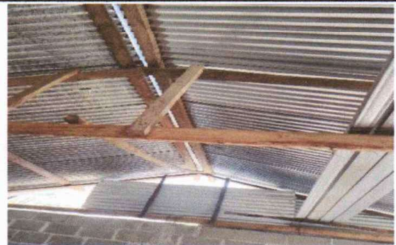
Foto 2: Sustrucción de estructura de techo de madera, por metal.
