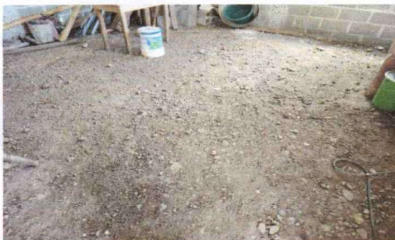
Foto 5: Sustrucción de piso de torta de concreto.
