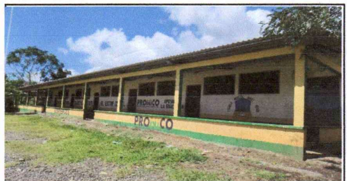
Foto 6: Pintura muros exteriores e interiores.
