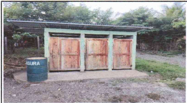
Foto 4: Sustrucción de puerta en sanitario de madera a metal.
