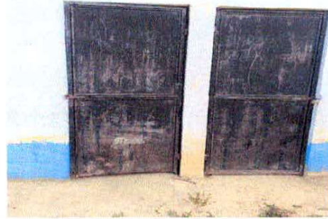
Foto 2: Sustitución de puerta en servicios sanitario
