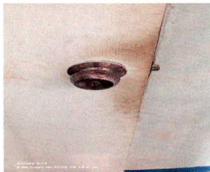
Foto 3: Sustitución de chapa
