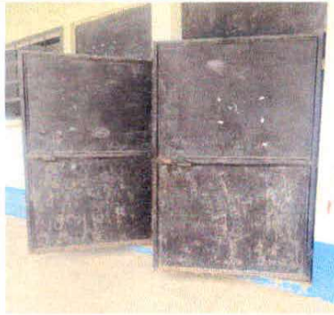
Foto1: Sustitución de puertas de metal
