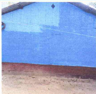
Foto1: Sustitución de lámina, por lámina troquelada aluzinc calibre 26.
