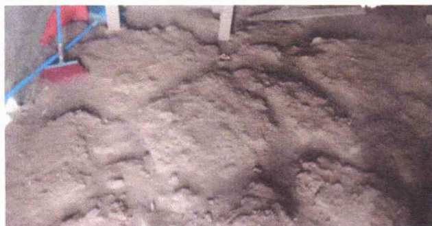
Foto 3: Sustitución de piso de torta de concreto.
