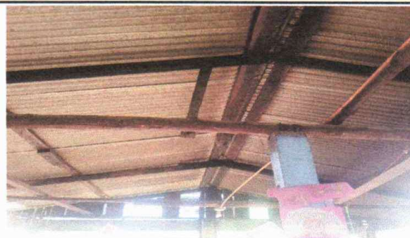
Foto 2: Sustitución de estructura de techo de madera, por metal.
