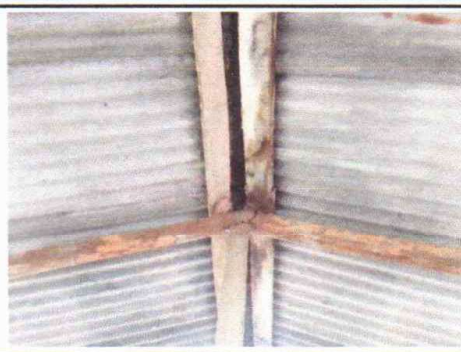
FOTO 2: SUSTITUCION DE ESTRUCTURA DE MADERA POR METAL
