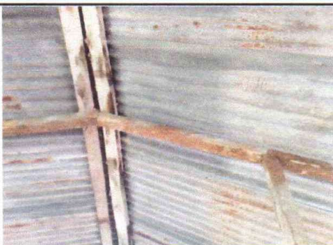
FOTO 1: SUSTITUCION DE LAMINA POR LAMINA TROQUEALDA
