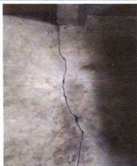
FOTO 3: REPARACION DE PISO TORTA DE CONCRETO
