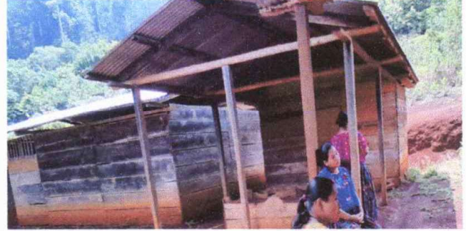
Foto 2: Sustrucción de estructura de techo de madera, por metal.
