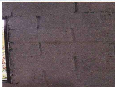
Foto 2: Repello en muro
