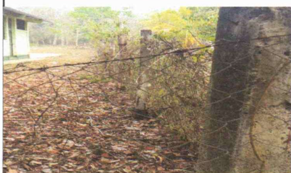
FOTO 3: Sustrución de malla y alambre espigado a mala 1.50 m
