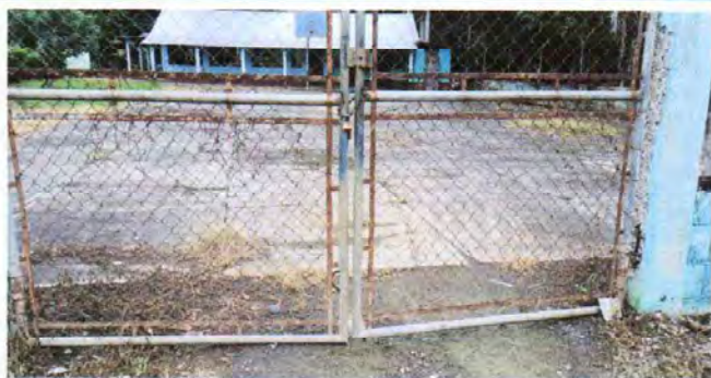
Foto 7: sustitución de portón de metal
