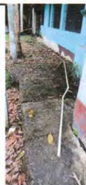
Foto 16: Sustrución de tubería agua potable
