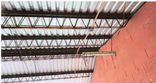
Foto 19: Sustitucion ducto eléctrico y sus accesorios
