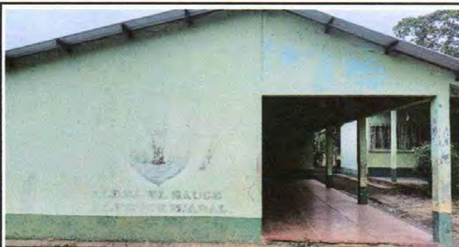
Foto 10: Pintura muro interior y exterior
