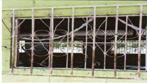
Foto 8: Mantenimiento de Balcones
