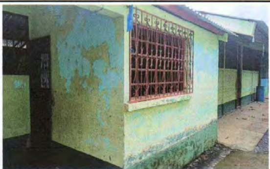
Foto 11: Pintura muro interior y exterior
