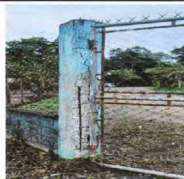
Foto 18: Reparación de columnas de concreto
