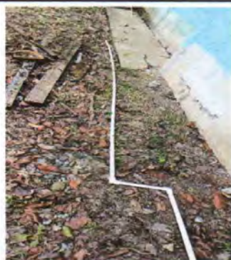
Foto 15: Sustrución de tubería agua potable
