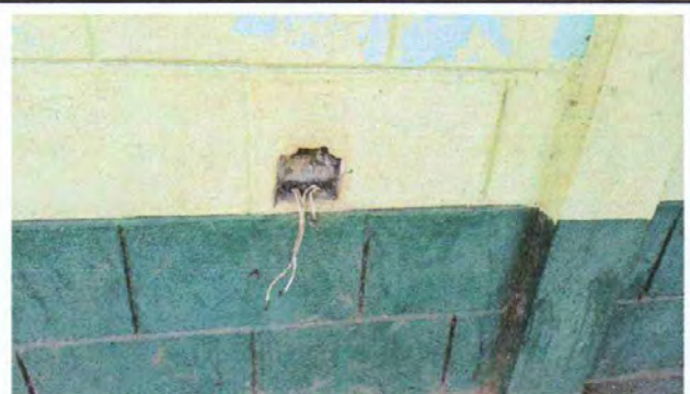
Foto 22: Sustitucion ducto eléctrico y sus accesorios
