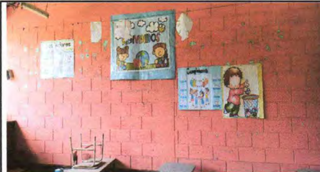
Foto 12: Pintura muro interior y exterior
