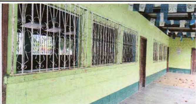
Foto 9: Mantenimiento de Balcones
