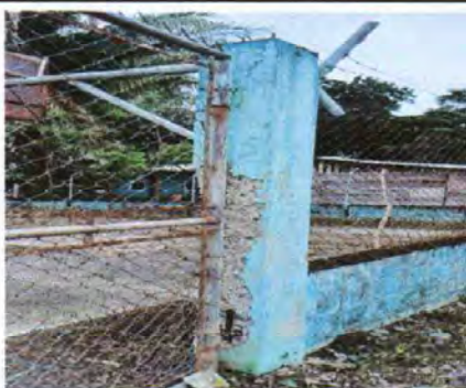
Foto 17: Reparación de columnas de concreto
