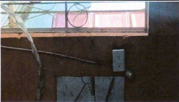
Foto 21: Sustitucion ducto eléctrico y sus accesorios
