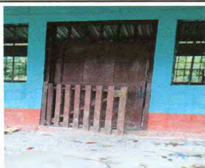
Foto 5: Sustrucción de puertas de madera por metal
