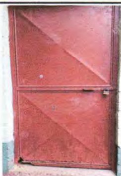
Foto 3: Mantenimiento a puertas de metal
