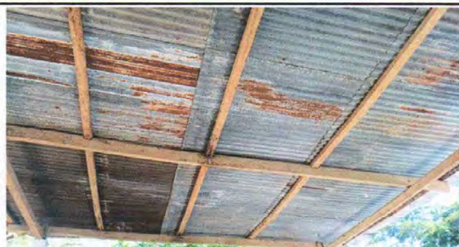
Foto 2: Sustrucción de estructura de madera por metal
