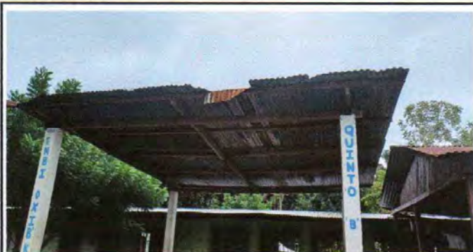
Foto 1: Sustrucción de lámina por lámina troquelada cal. 26
