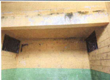
Foto 5: PINTURA EN MUROS INTERIOR Y EXTERIOR
