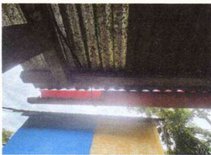
FOTO 3: SUSTITUCION DE CANALES DE PVC
