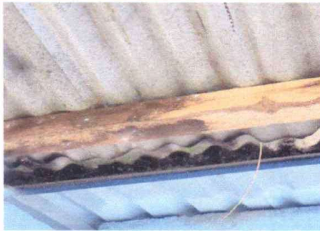
FOTO 1: SUSTITUCION DE LAMINA POR LAMINA TROQUEALDA
