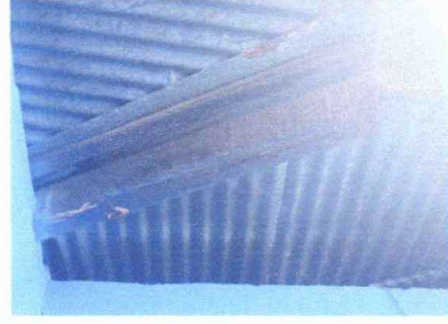
FOTO 2: MANTENIMIENTO DE ESTRUCTURA DE METAL
