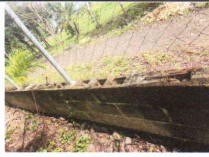
Foto 6: REPARACION DE MURO PERIMETRAL
