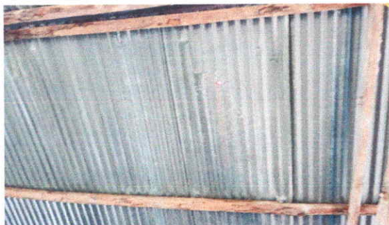
Foto1: Sustitución de lámina, por láminas troqueladas Aluzinc calibre 26
