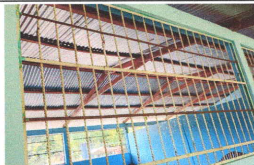
Foto 4: Mantenimiento a balcones de metal
