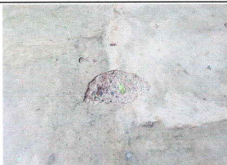
Foto 5: Sustitución de piso de torta de concreto
