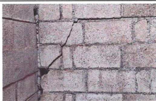
Foto 6: Reparación, repello y cernido de paredes
