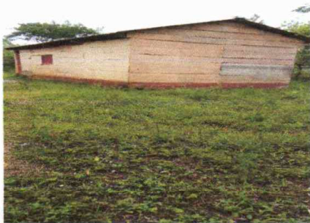
Foto 5: Remodelación de culmina de concreto
