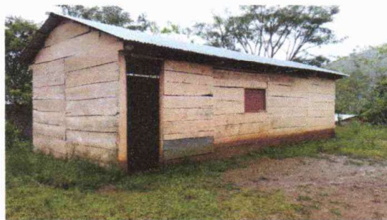
Foto 4: Sustitucion de puerta de madera por metal
