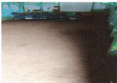
Foto 3: Sustitución de piso de torta de concreto .
