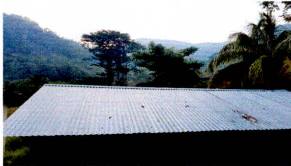
Foto 1: Sustrucción de láminas aluzinc por láminas troqueladas calibre 26
