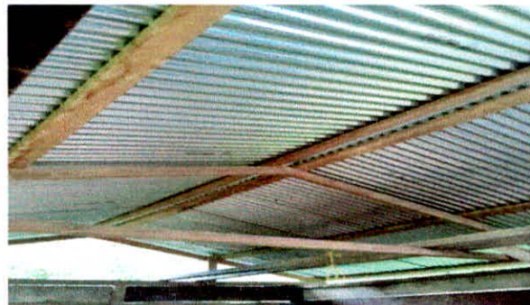
Foto 2: Sustrucción de estructura de madera por estructura de metal
