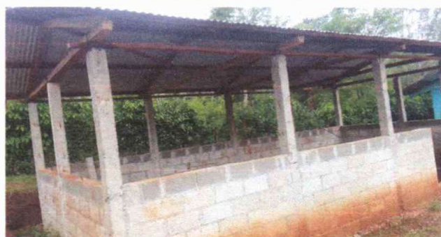
Foto 4: Sustrucción balcones de metal
