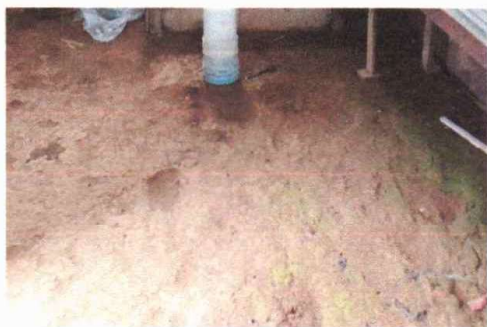
Foto 3: Sustrucción de piso de torta de concreto .
