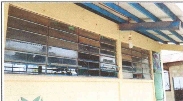
Foto 1: Sustitución de balcones de metal
