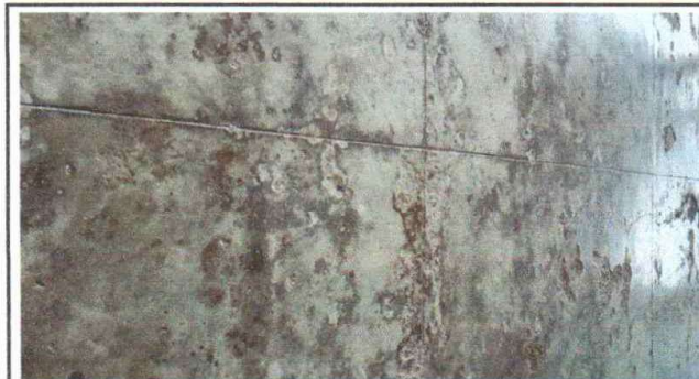
Foto 3: Sustitución de piso de torta de concreto
