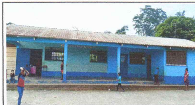
Foto 6: Pintura en muros exteriores e interiores
