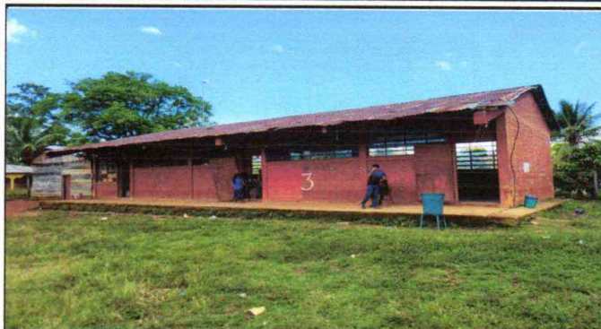
Foto 1: Sustitución de láminas, por láminas troqueladas aluzinc calibre 26
