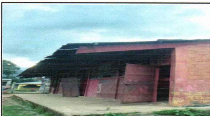
Foto 3: Sustitución de puertas de metal
