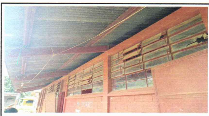
Foto 4: Sustitución de vidrios
