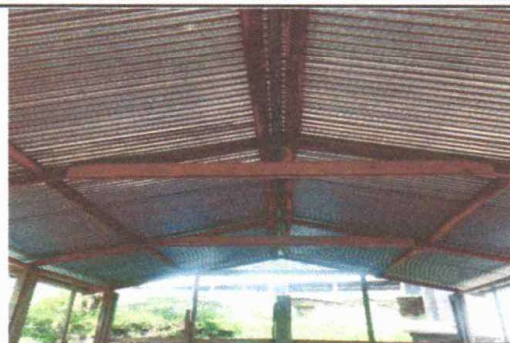
Foto 2: Sustrucción de estructura de techo de madera, por metal.
