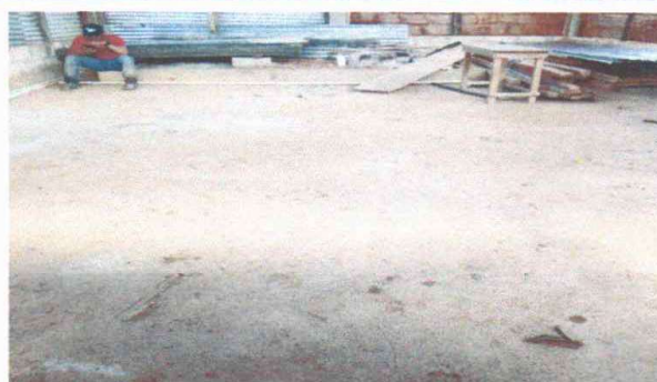
Foto 4: Reparación de piso de torta de concreto.
