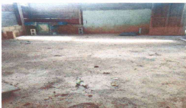
Foto 3: Reparación de piso de torta de concreto.
