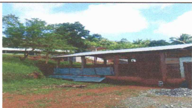
Foto 5: Reparación de columnas de concreto.
