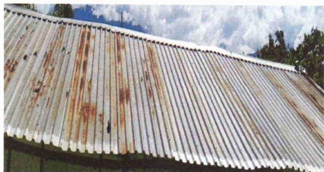
Foto1: SUSTITUCION DE LAMINA ALUZINC Y LAMINAS TROQUELADAS CALIBRE 26
