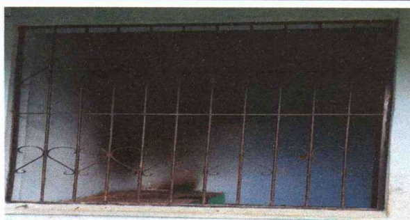
Foto 5: SUSTITUCION DE BALCONES Y VENTANAS
