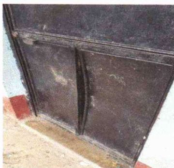
Foto 3: SUSTITUCION DE PUERTA DE METAL
