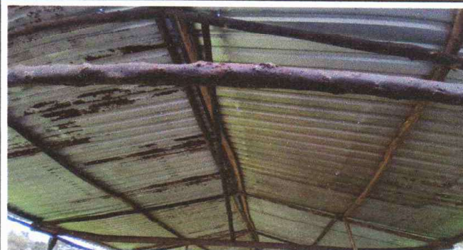
Foto 2: SUSTITUCION DE ESTRUCTURA DE MADERA POR ESTRUCTURA DE METAL
