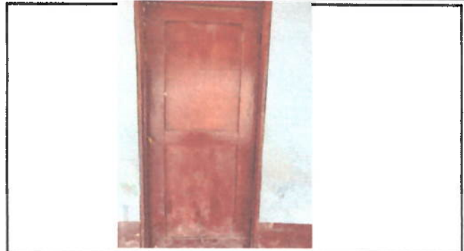
Foto 2: SUSTITUCION DE PUERTAS DE METAL
