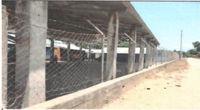
FOTO 1: REPARACION DE MURO PERIMETRAL DE BLOCK CON MALLA
