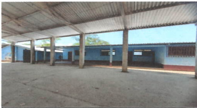
Foto 5: PINTURA INTERIOR Y EXTERIOR
