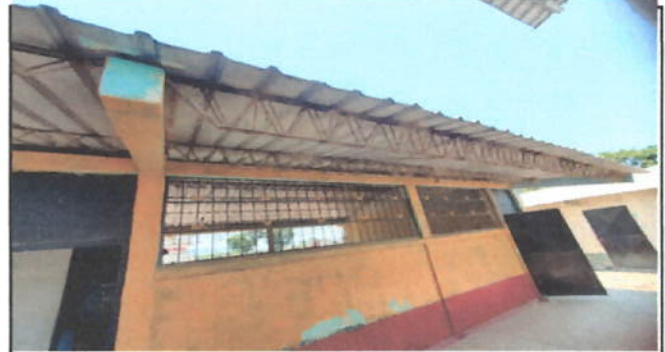
Foto 4: MANTENIMIENTO DE BALCONES DE METAL
