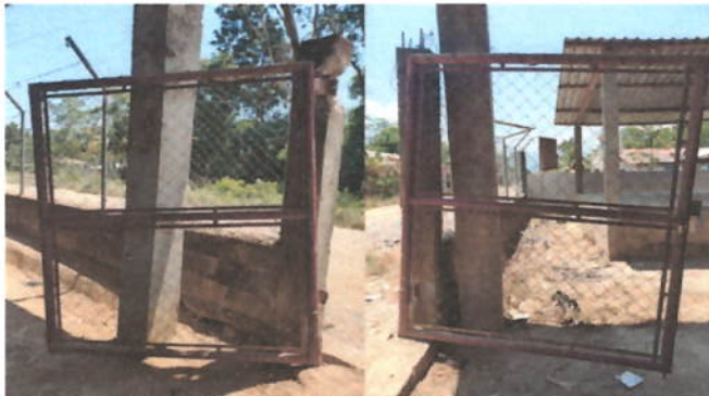
Foto 3: SUSTITUCION DE PORTON DE METAL
