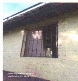
Foto 4: Sustitución de estructura de metal de ventana
