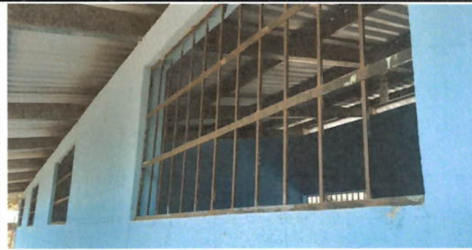
Foto 2: MANTENIMIENTO A ESTRUCTURA DE SOPORTE DE METAL
