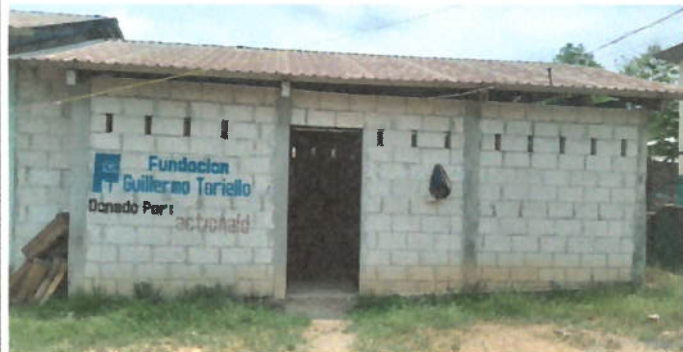
Foto1: REPARACION DE REPELLO Y CERNIDO DE PAREDES
