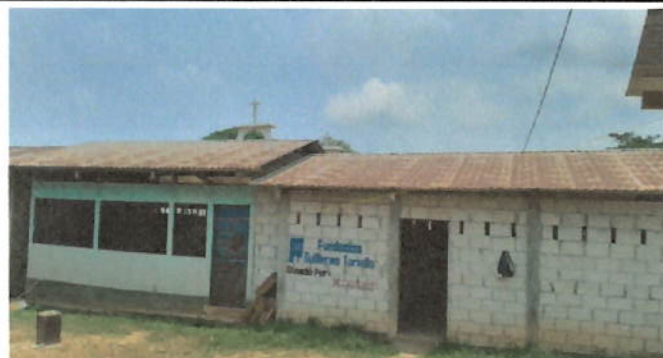
Foto1: MANTENIMIENTO DE LÁMINA TROQUELADA
