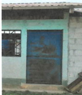
Foto 3: PUERTAS DE METAL MANTENIMIENTO A ESTRUCTURA
