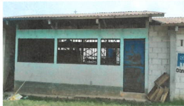
Foto 6: PINTURA EN MUROS EXTERIORES E INTERIORES
