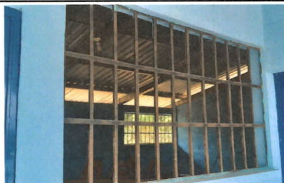
Foto 4: MANTENIMIENTO A BALCONES DE METAL
