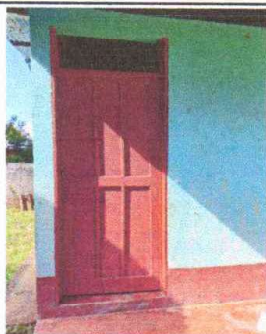
Foto 3: Sustrucción de puertas
