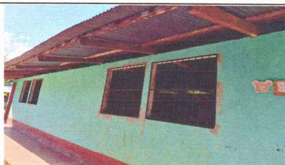
Foto 4: Reparación y Elevación de altura de paredes
