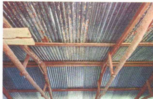
Foto 2: Sustrucción de estructura de soporte de madera, por metal
