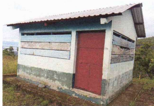
FOTO 2: SUSTITUCION DE VENTANAS DE MADERA POR METAL Y VIDRIO
