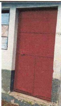
FOTO 1: MANTENIMIENTO DE PUERTA DE METAL
