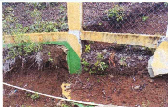
FOTO 6: REPARACION DE MURO PERIMETRAL
