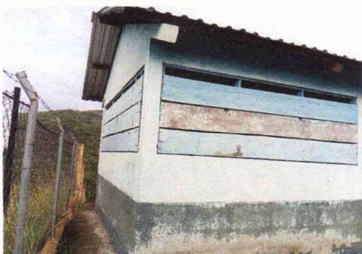
FOTO 3: INSTALACION DE CANALES Y BAJADAS DE AGUA
