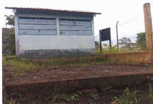
FOTO 4: PINTURA EN MUROS INTERIOR Y EXTERIOR
