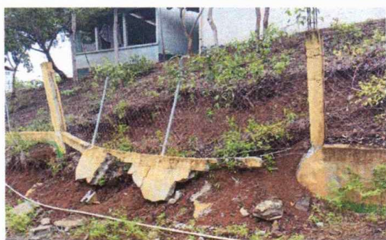
FOTO 5: REPARACION DE MURO PERIMETRAL
