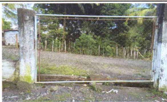
Foto 4: Mantenimiento a estructura de Portón
