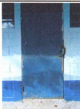
Foto 3: Mantenimiento a estructura de Puertas de Aulas y Dirección, Sustitución de Chapas
