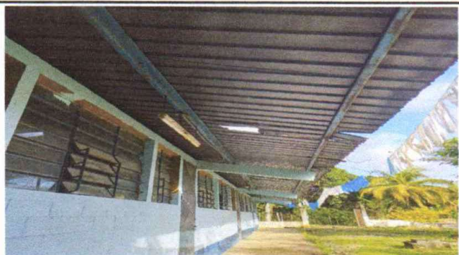
Foto 1: Sustitución de lámina, por lámina troquelada calibre 26
