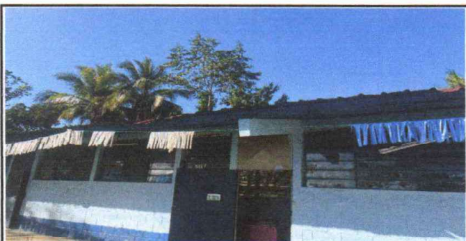
Foto 5: Pintura en muros exteriores e interiores
